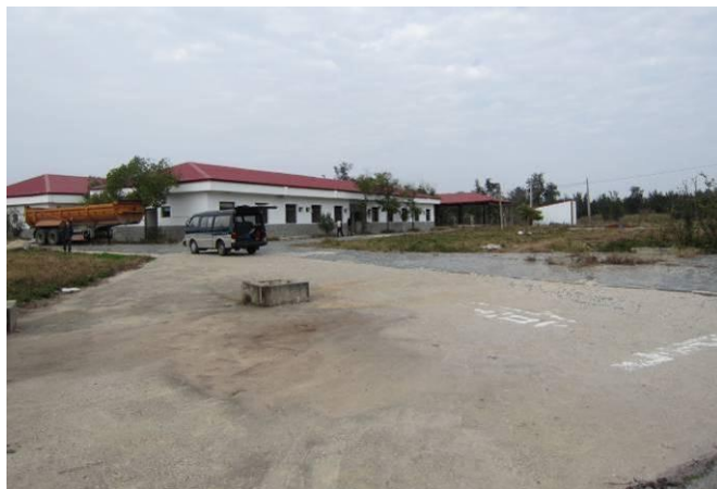
View A 基地南側現況
