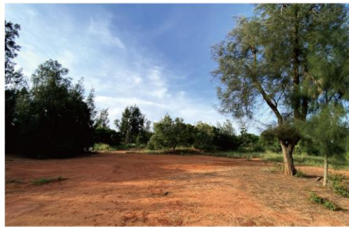
11 現況為整地中空地
