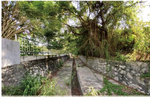
4 現況溝渠使用
