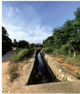
8 現況溝渠使用
